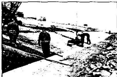
Thi công phân đập đất
