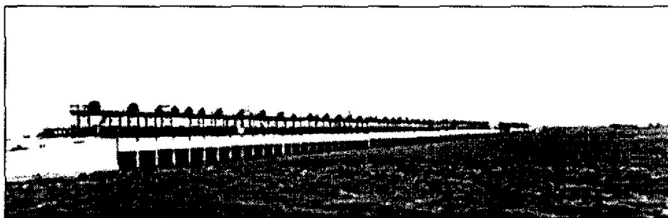
Hình 2.6. Phần đập Brouwers được xây dựng theo phương án xà lan
