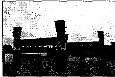
Hình 3.72. đập chắn sóng Hollandse IJssel
