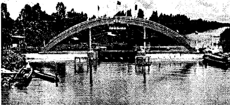
Hình 1.7. Công trình đập Xà lan cống Rạch Lùm (Cà Mau)
