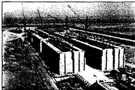
Thi công đúc xà lan trong hố móng
