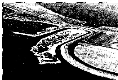
Toàn cảnh công trình khi hoàn thiện
