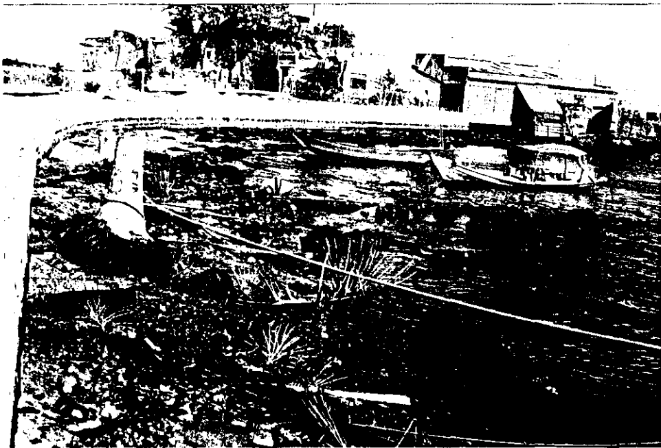
Ảnh 4.8 Xói lở làm trợ rã đê ở bắc cửa Dương Đông
