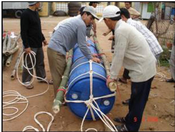
Hình 23. Thi công phao chà (phi nhựa)
