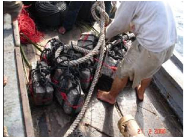
Hình 7.4.4. Chuẩn bị hệ thống đá dằn neo
