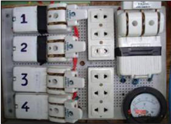
Hình 7.2.3. Cầu dao điện cao áp
