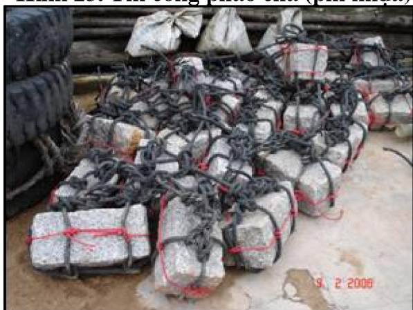
Hình 25. Hệ thống đá dằn neo
