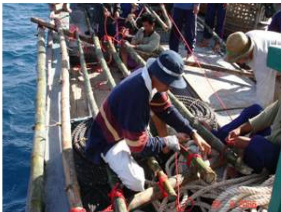
Hình 7.4.5. Thi công bè tre tam giác
